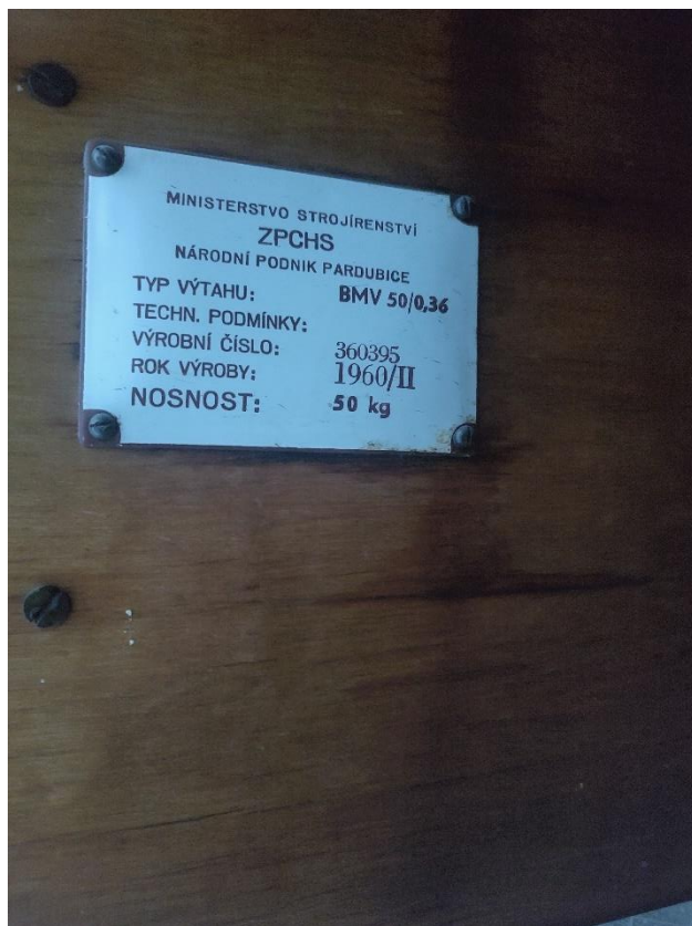
Štítek na vnitřní straně kabiny výtahu
