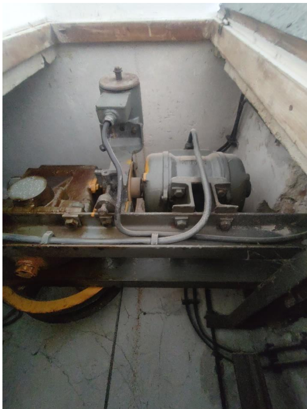
Pohled na strojovnu výtahu na kabinou
