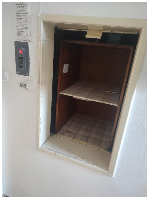
Kabina výtahu vč. ovládání.
